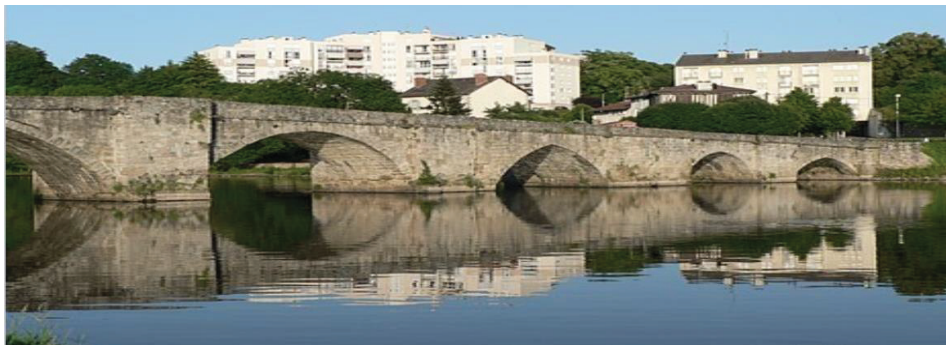
Figure I.1 Exemple de pont voûtés
