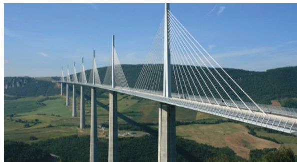
Figure I.7 Exemple d'un pont haubans
