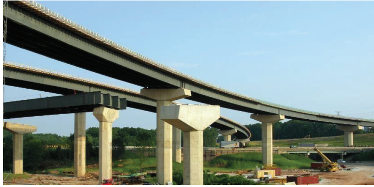
Figure I.3 Exemple ponts mixtes
