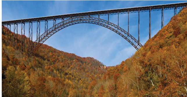
Figure I.5 Exemple pont en arc
