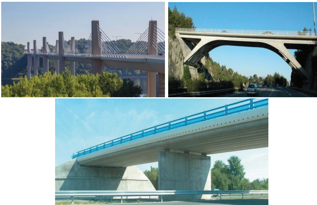
Figure I.2 Exemple des ponts en béton précontraint.
