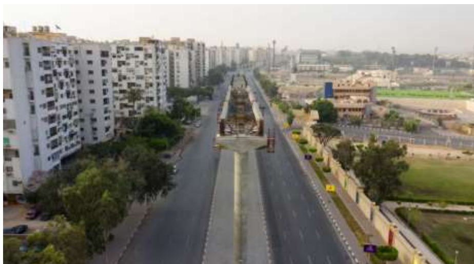
Figure I-7 : Ligne Monorail Caire-Nouveau capitale administrative (EGYPT) en chantier Projet monorail en TPC
