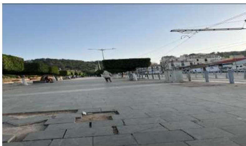
Figure III-11 La placette de ruisseau (les fusilles) :
