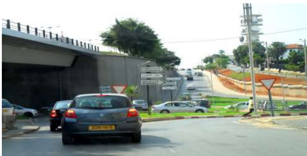
Figure III- 4-PK9 +700 : Fin de projet en TPC de la RN5
