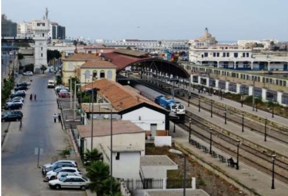
Figure II-5: Gare centrale d'Alger
