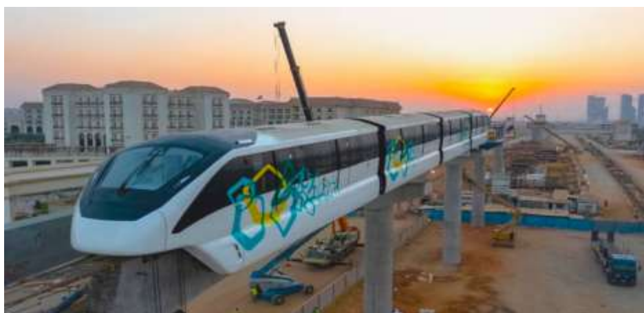
Figure I-8 : Ligne Monorail Caire-Nouveau capitale administrative (EGYPT) en chantier Les essais sur rail-2021
