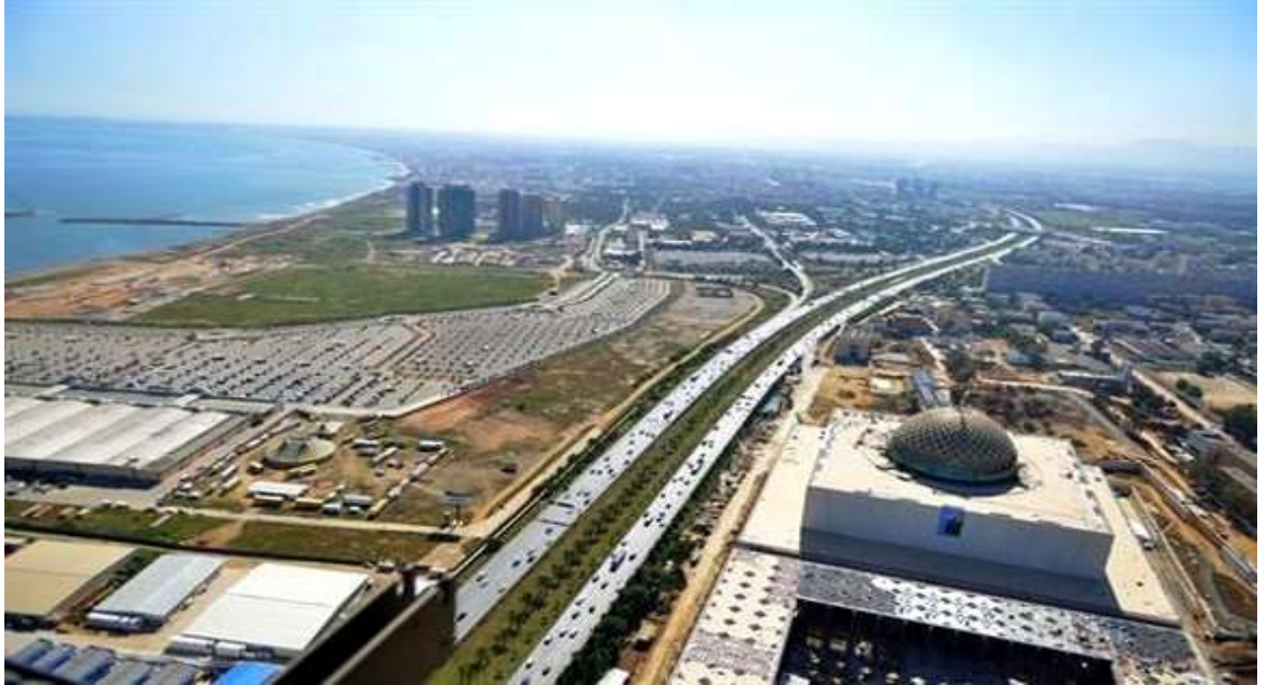
Figure III-2 : Vue de la future ligne de monorail en TPC de la RN11
