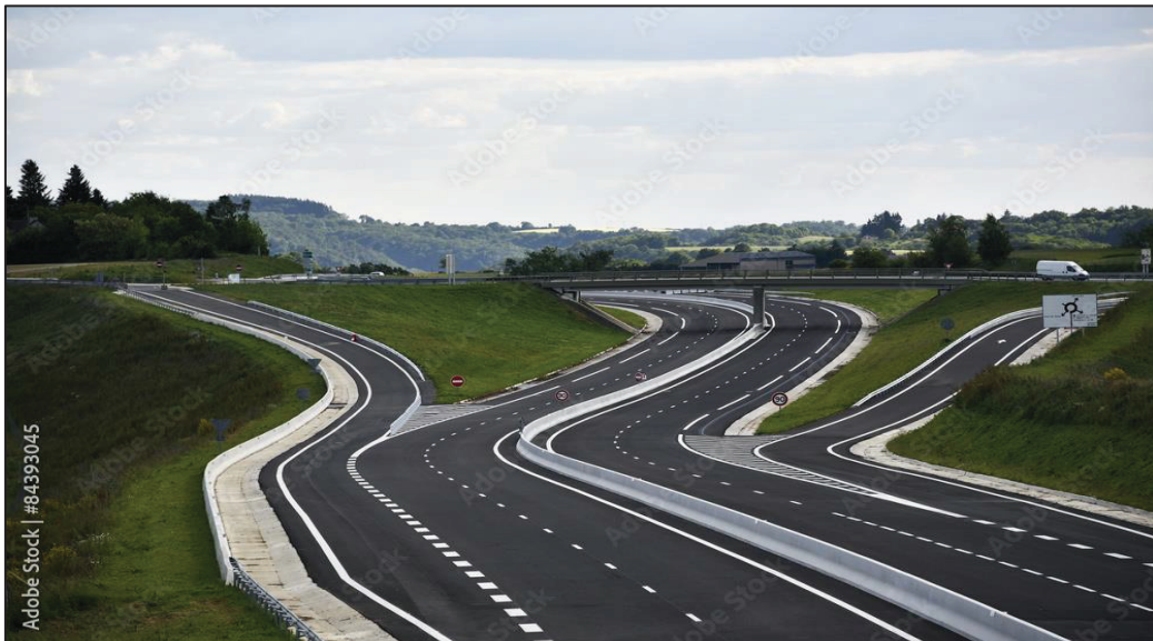
Figure I-1 : Echangeur sur une voie express
