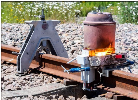
Figure IV.4 : soudage aluminothermique
