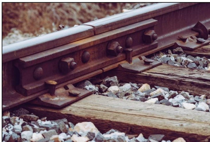
Figure IV.3 : assemblage par éclissage
