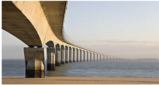
Figure II. 4 Pont de l'île de Ré
