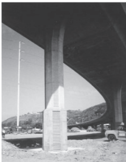
Figure I. 5 Rénovation d'une colonne à enveloppe en béton
