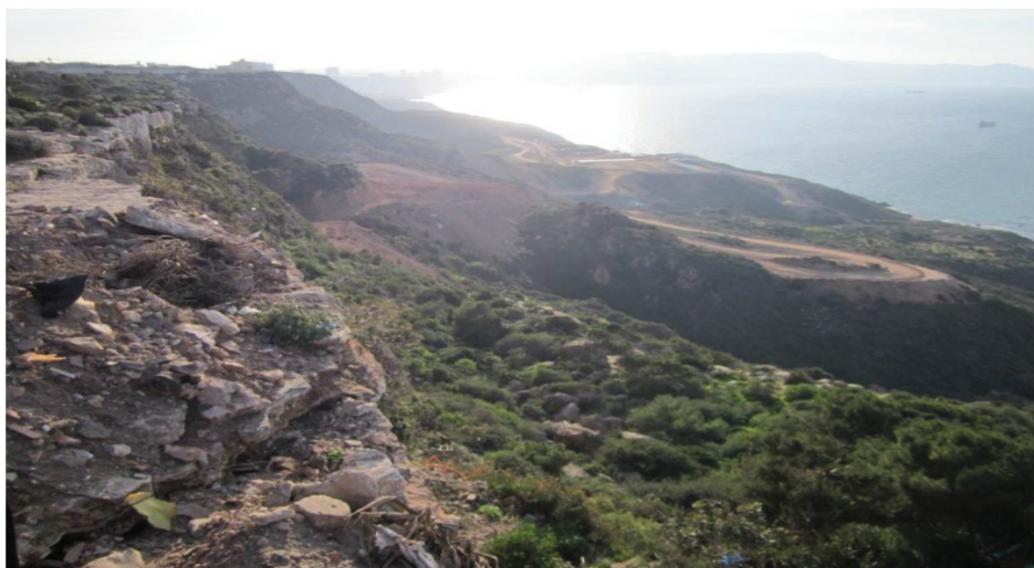
Figure II. 11 Localisation du viaduc
