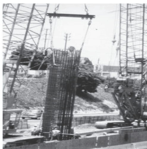
Figure I. 8 Cage en acier pour le renforcement des colonnes.
