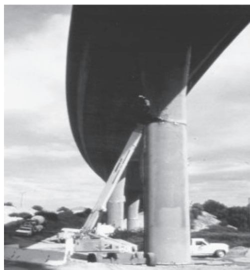
Figure I. 6 Rénovation d'une colonne à enveloppe en acier.
