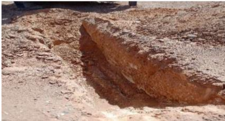
Figure VI- 10: Puits № 07 au PK 122+775
