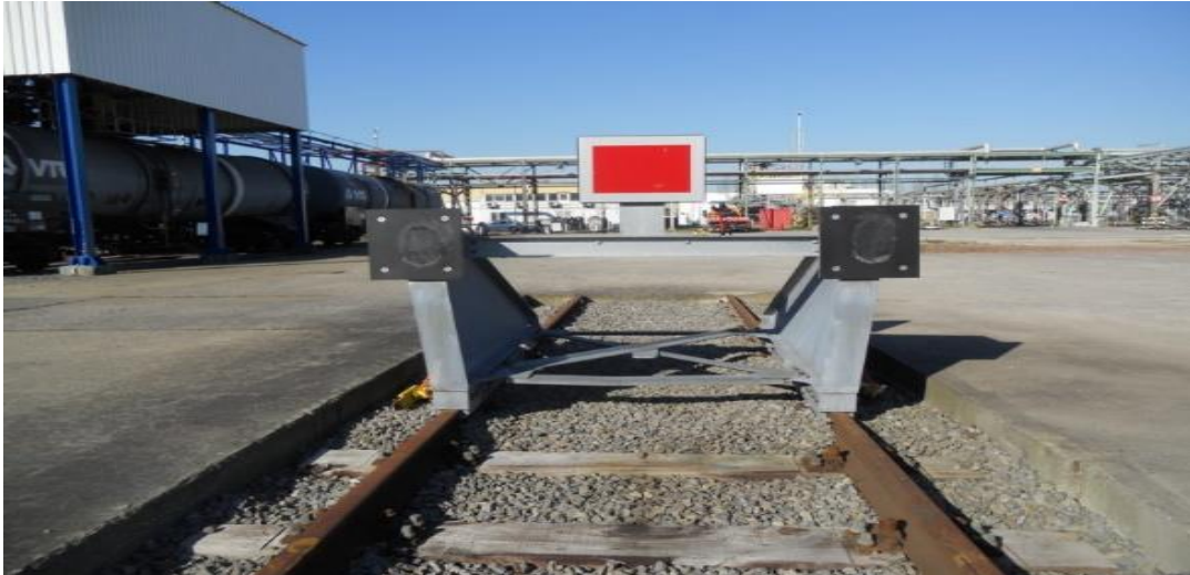
Figure X-6 : Heurtoir de fin de voie en gare
