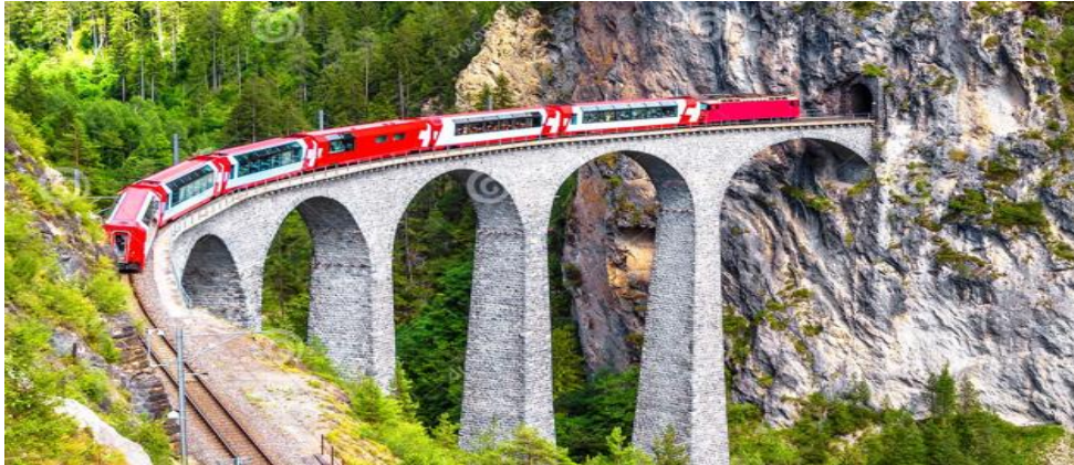
Figure I. 3: Pont en arc (Suisse).
