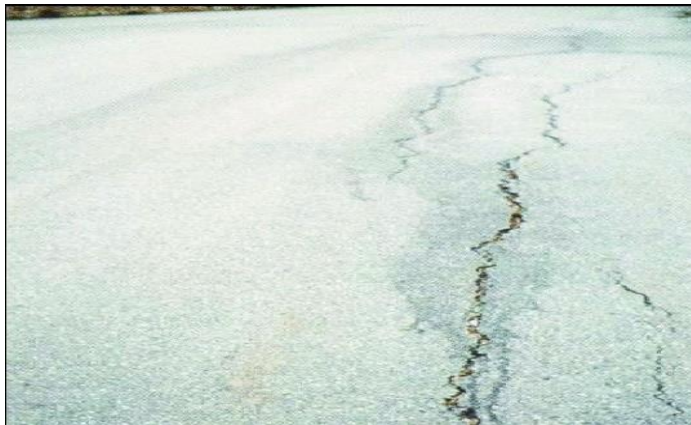
FIGURE 2 FISSURE LONGITUDINALE
