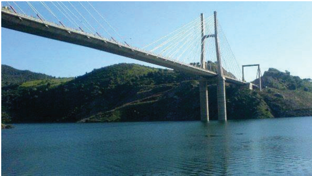
Figure I. 7 Affouillement autour des appuis du pont enjambant la cuvette du barrage de Beni Haroun
