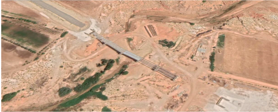
Figure II. 1 Image satellite sur le pont ferroviaire PK230+100
