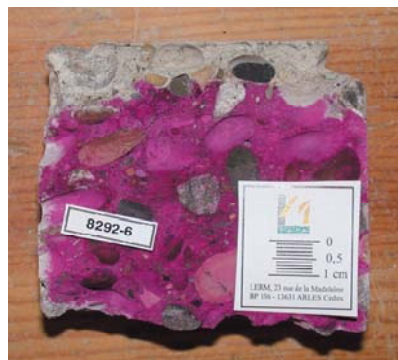
Figure 4.12 Mise en évidence de la carbonatation par phénolphtaléine (LERM, 2006)
