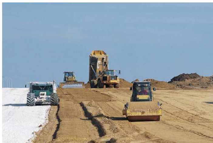
Figure 2.34 Exemple de traitement de sol à la chaux.
