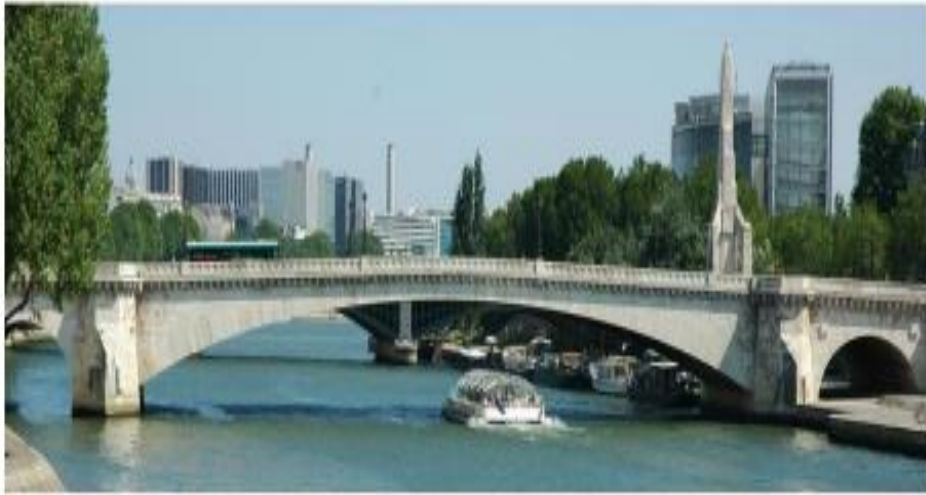
Figure I.04 : Pont en arc en béton
