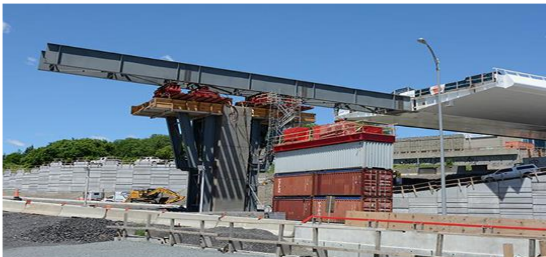
Figure I.16 : Construction d'un pont poussé
