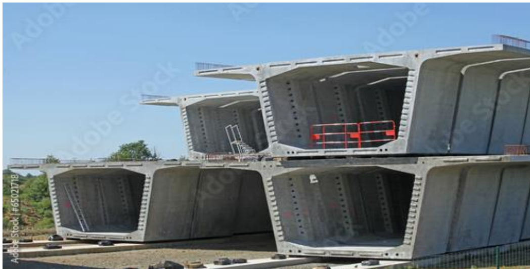
Figure I.09 : Pont construit en éléments préfabriqués
