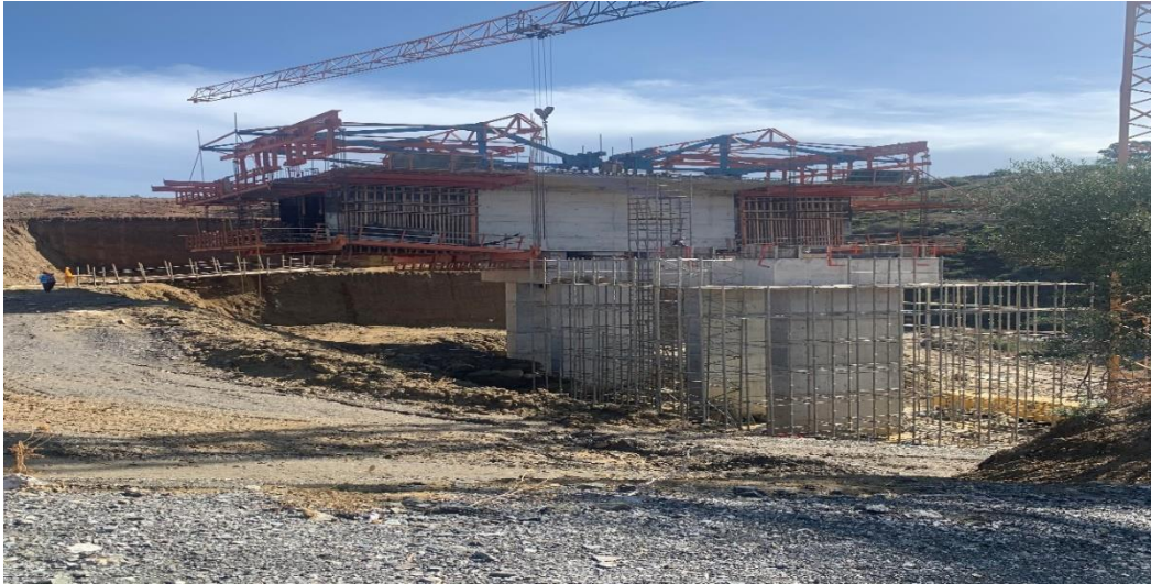
Figure I.10: Voussoir coulée en place (V1 – Boumerdes)
