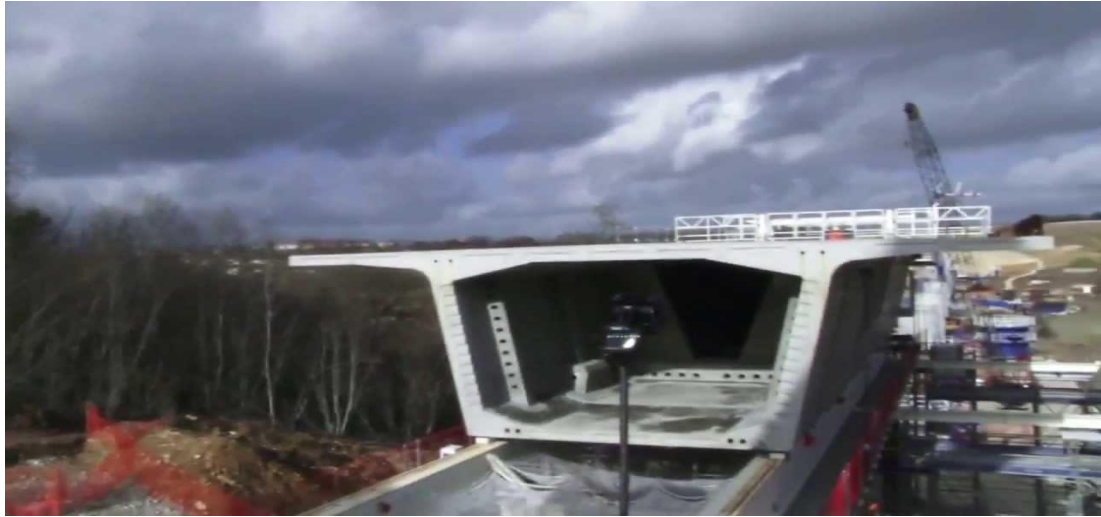
Figure I.08 : Construction du pont à voussoirs
