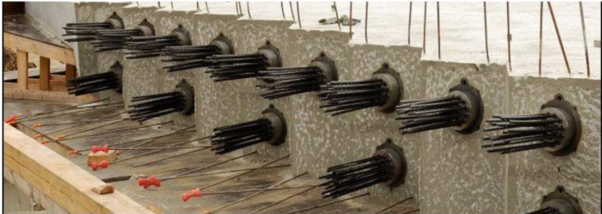
Figure III.01 : Les câbles de précontraintes
