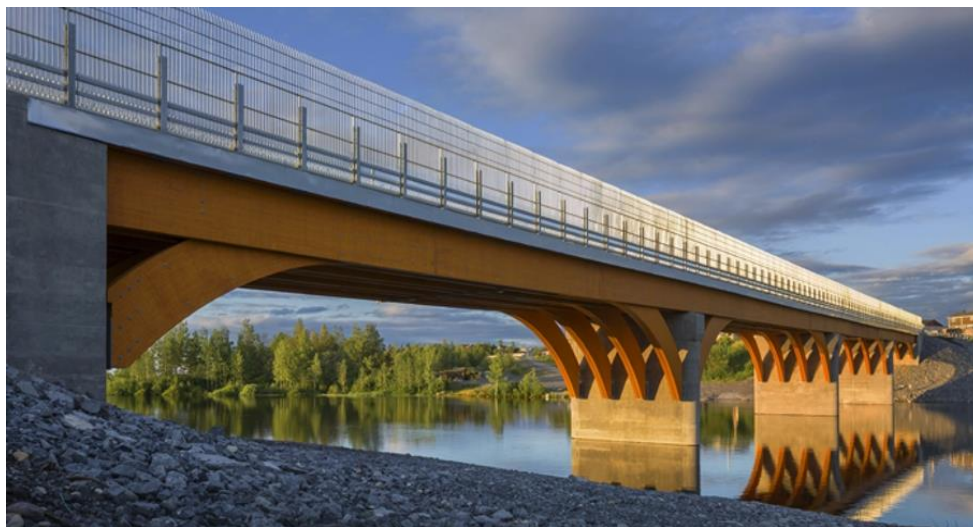
Figure I.01 : Pont en bois
