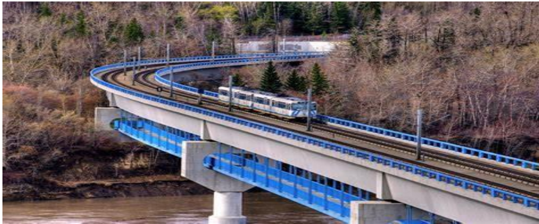
Figure I.15 : Pont de Light Rail Transit de Calgary
