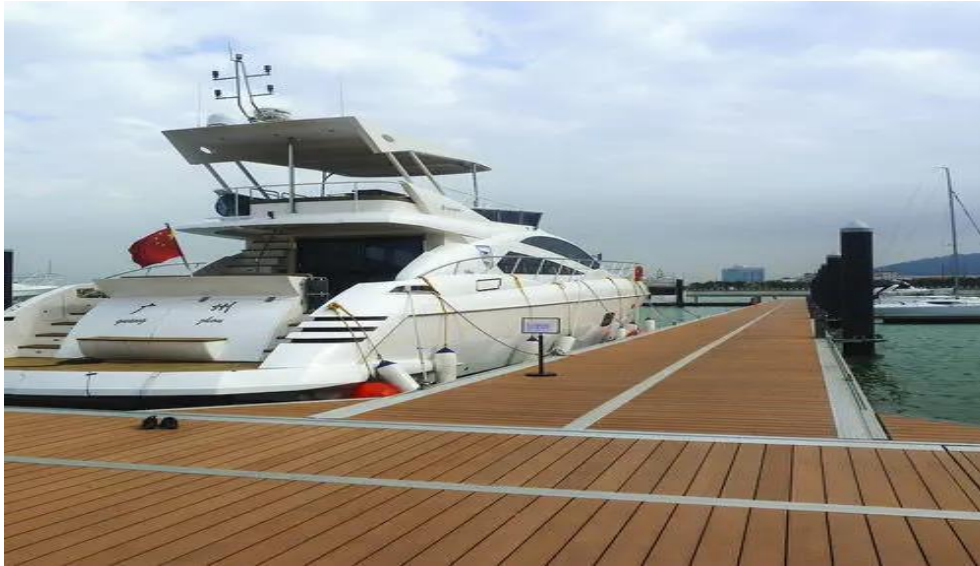
Figure VI.9. Vue générale d'un appontement flottant dans un port de plaisance.
