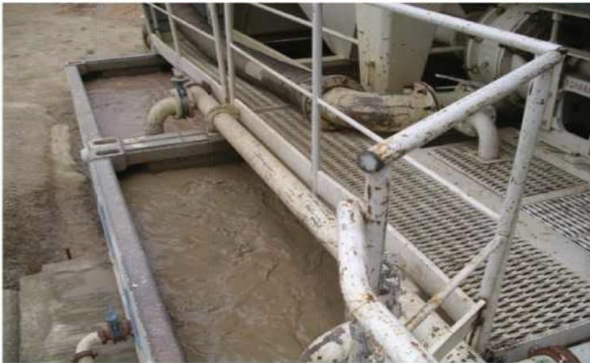
Figure V.1 : la boue bentonitique
