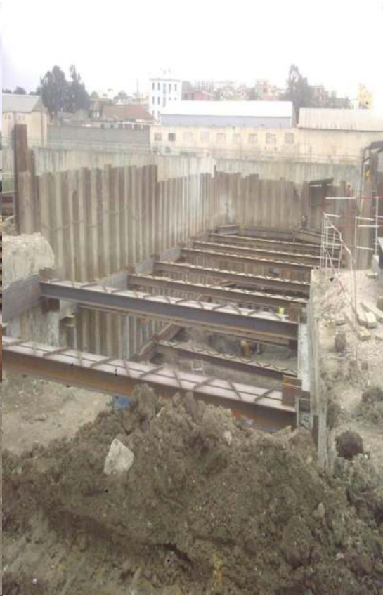
Figure V.15: Étayage des palplanches
