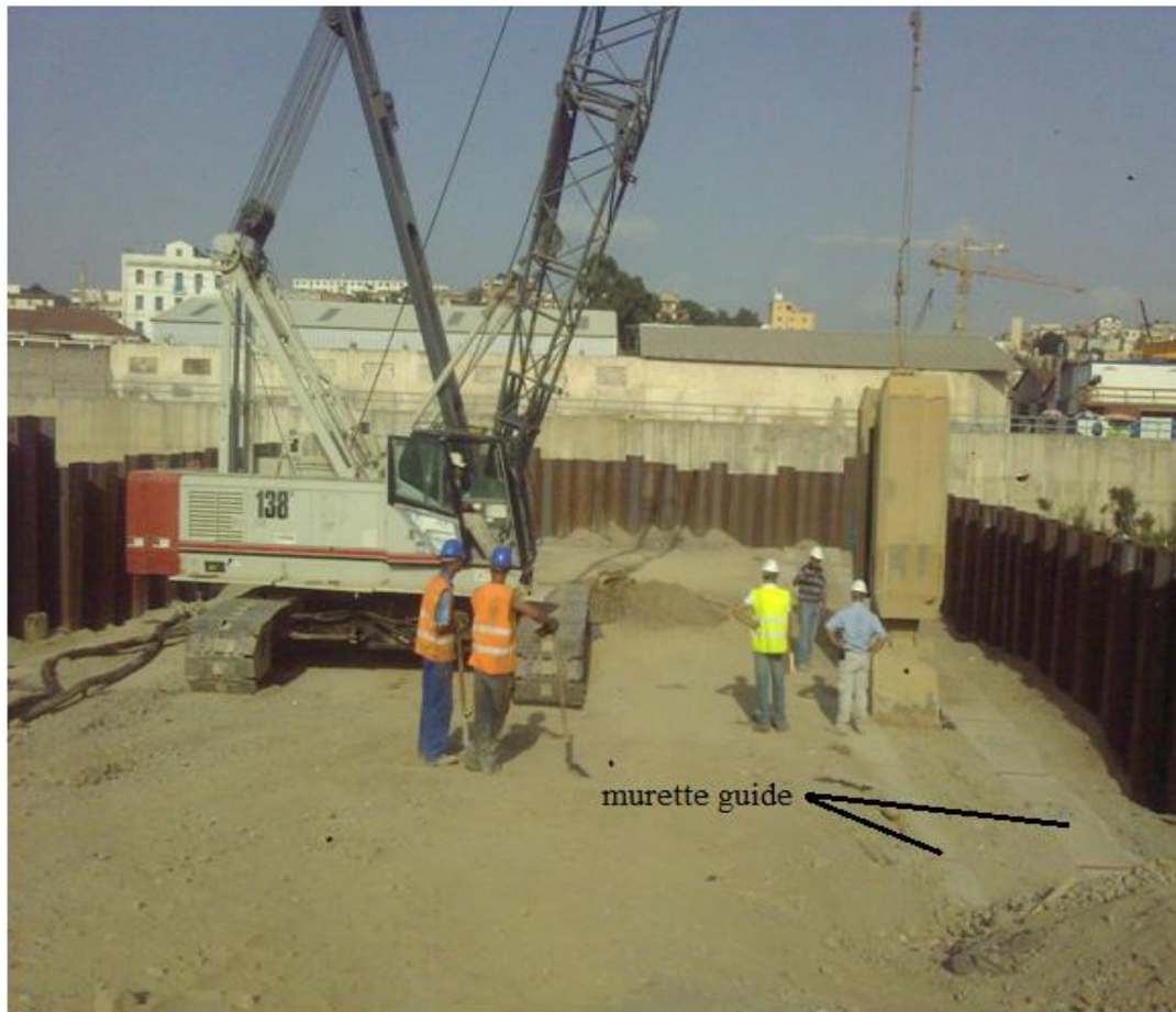
Figure V.10 : Excavation sous protection des murettes guide
