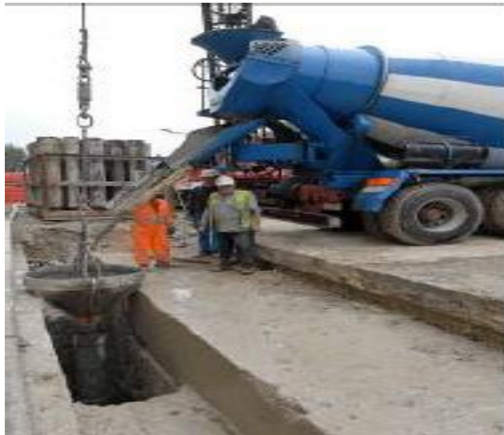
Figure V.3: bétonnage de la paroi
