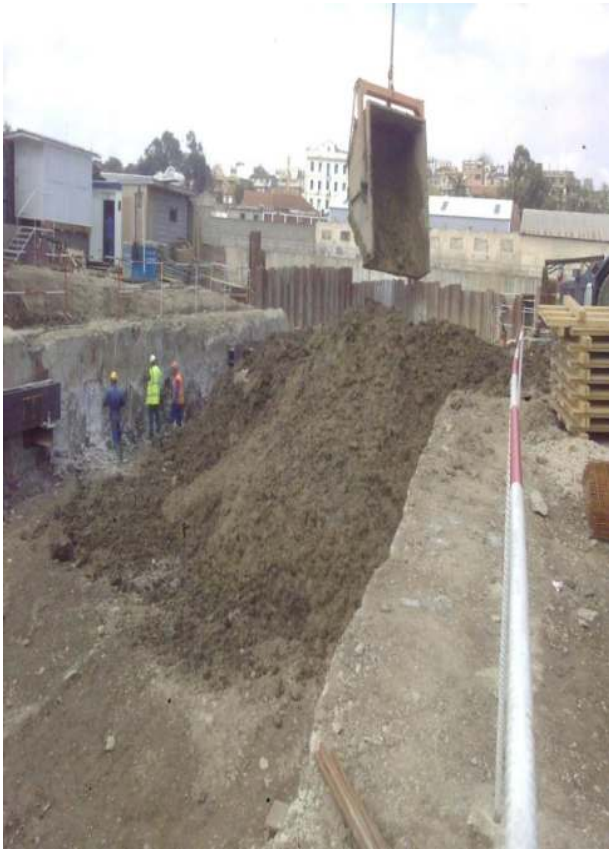
Figure V.14 : Excavation du remblai « Section I »
