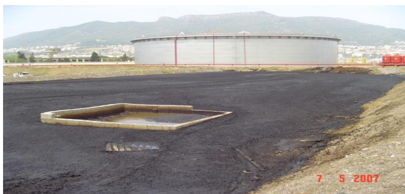
Figure III.1. Excavation aménagée de stockage des résidus pétrolier
