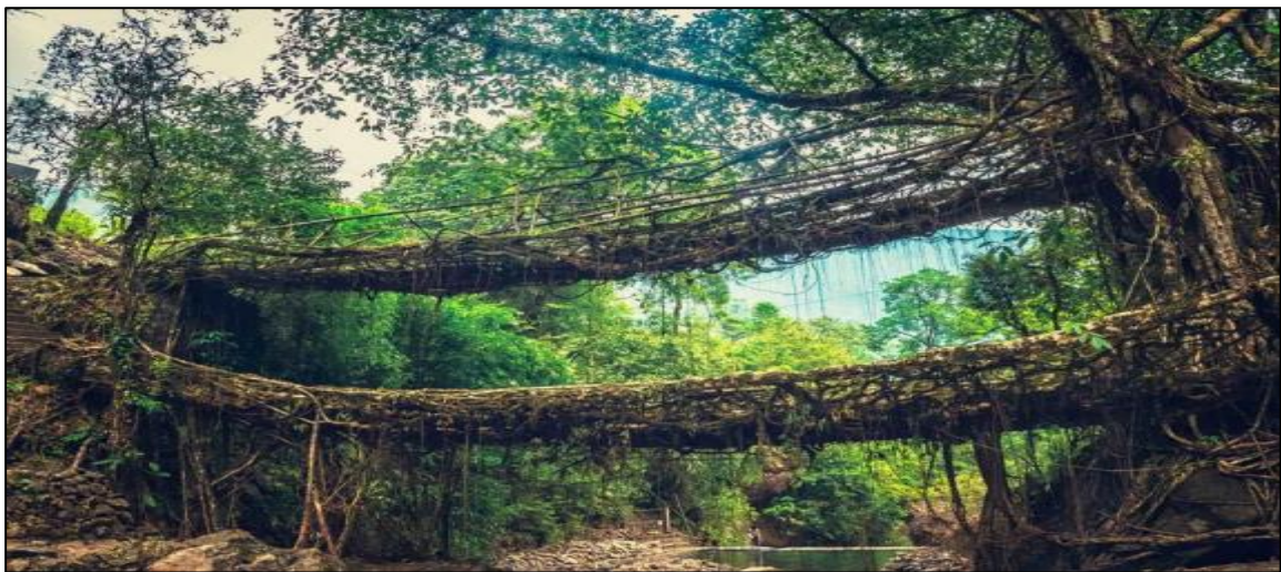
Figure.I. 1 : Pont de racines vivantes.
