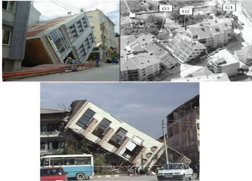
Figure I.4. Bâtiments renversés (séisme de Kocaeli, Adapazari en 1999) [3]
