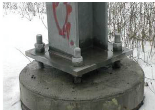
Figure XIII. 8:Un massif de la caténaire
