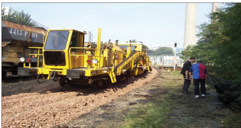
Figure I. 6: Bourreuse sur chantier. [11]
