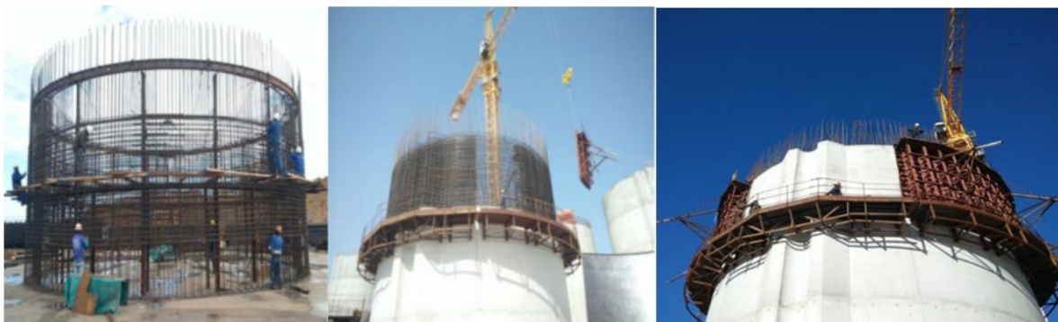
Figure II.20 : les différents travaux de la préfabrication du caisson
