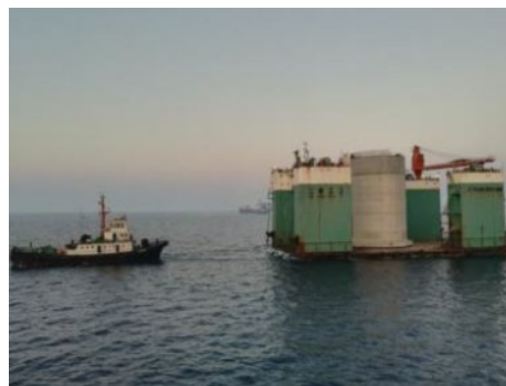
Figure II.22 : Transport sur l'eau et positionnement du caisson
