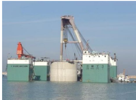
Figure II.23 : Plongée de la barge semi-submersible et déchargement de la barge
