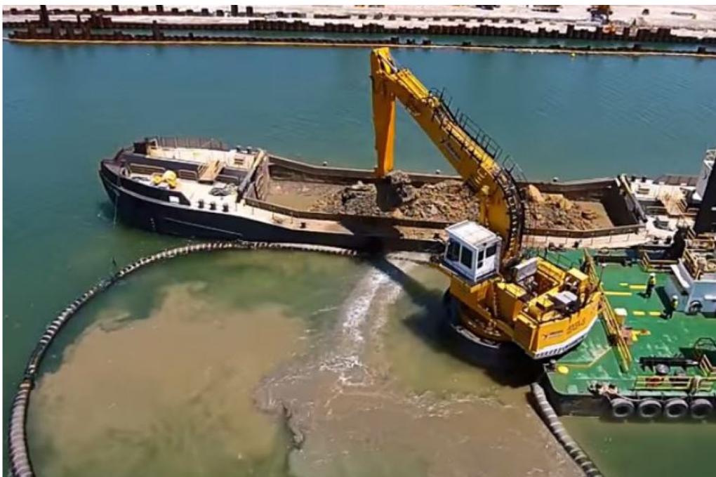
Figure VI.3 : utilisation d'un écran anti-turbidité dans une opération de dragage
