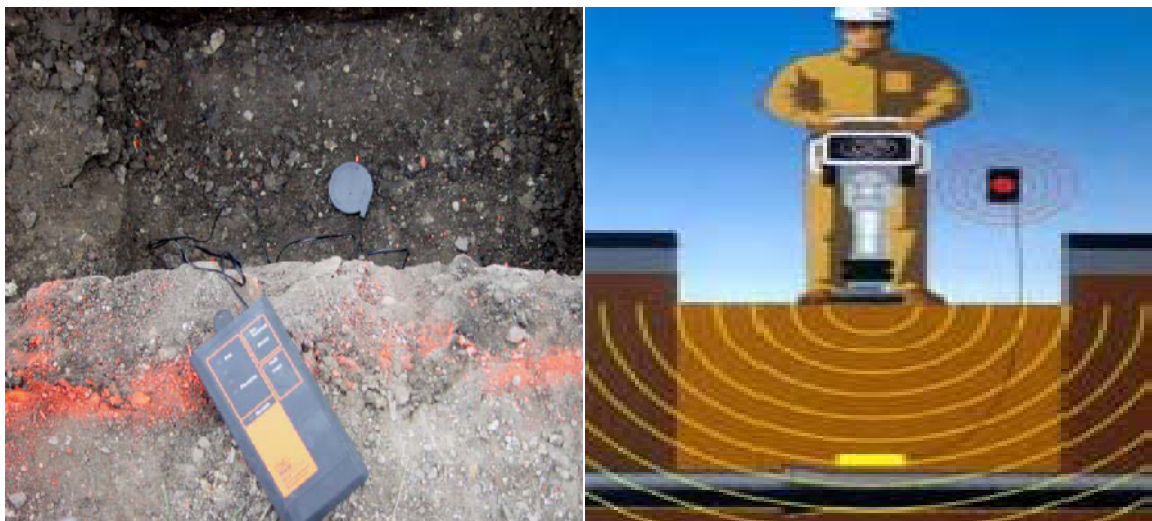
A CCS capteur avec le disque au fond de la tranchée (APWA; 2005)
