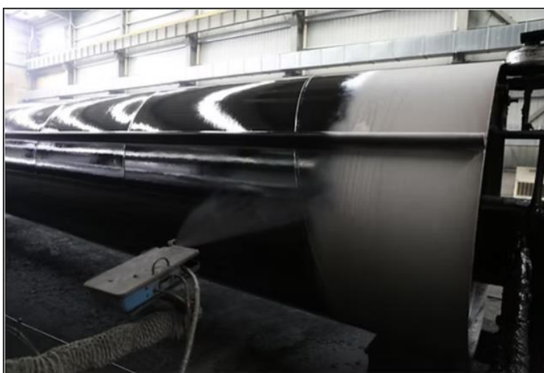
Figure 73. Application de peinture.
