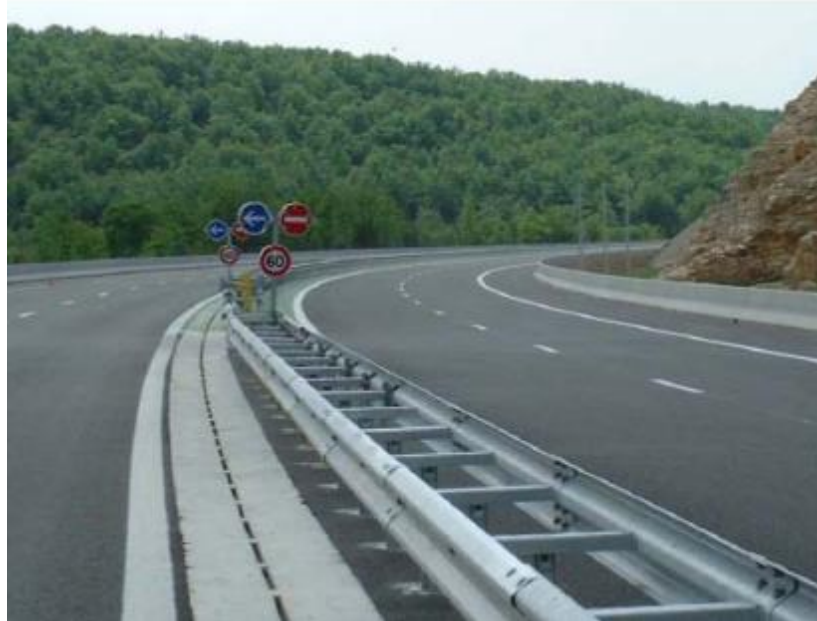
Figure VIII.4: Exemple de caniveau à fente
