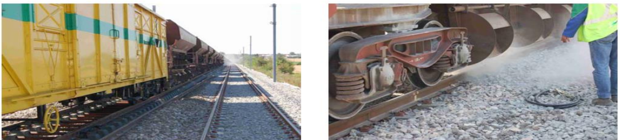
Figure N°II. 4-Illustration du déchargement du ballast
