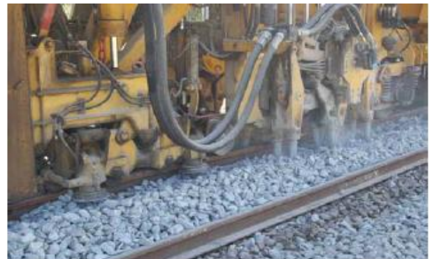
Figure N°II. 5-Illustration de la mise à niveau de la voie
