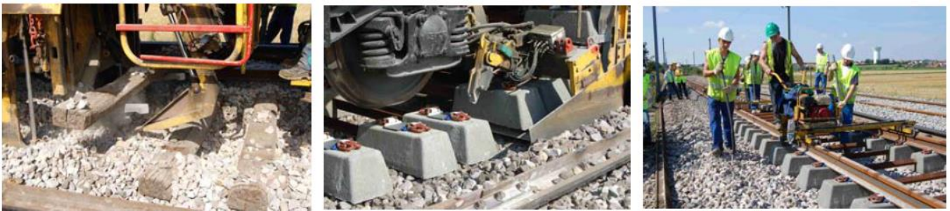
Figure N°II. 3-Illustration de la substitution des traverses et de la fixation des LRS
