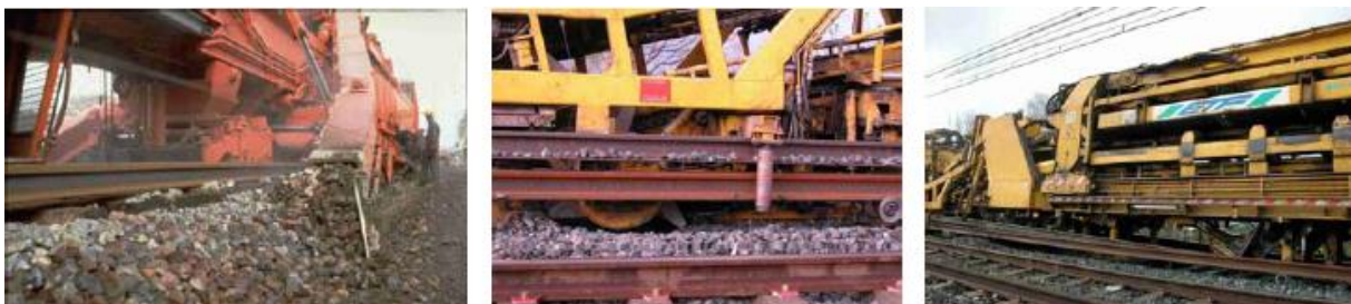
Figure N°II. 2-Illustration du dégarnissage de la voie
