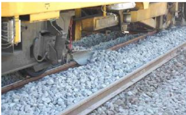
Figure N°II. 5-Illustration de la mise à niveau de la voie
