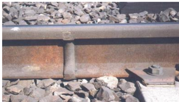
Figure N°I 8-Soudage aluminothermique
