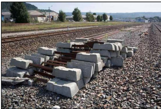
Figure I-7 : Traverse bi-bloc
