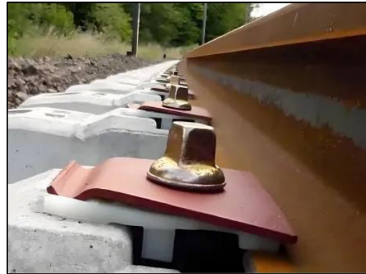
Figure I-10 : Système d'attache NABLA
