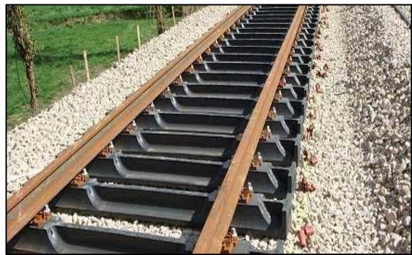
Figure I-8 : Traverse Métallique
