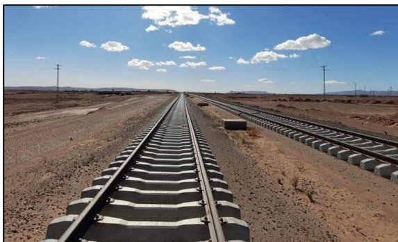
Figure I-3 : : Voie ferrée réalisée en Algérie
