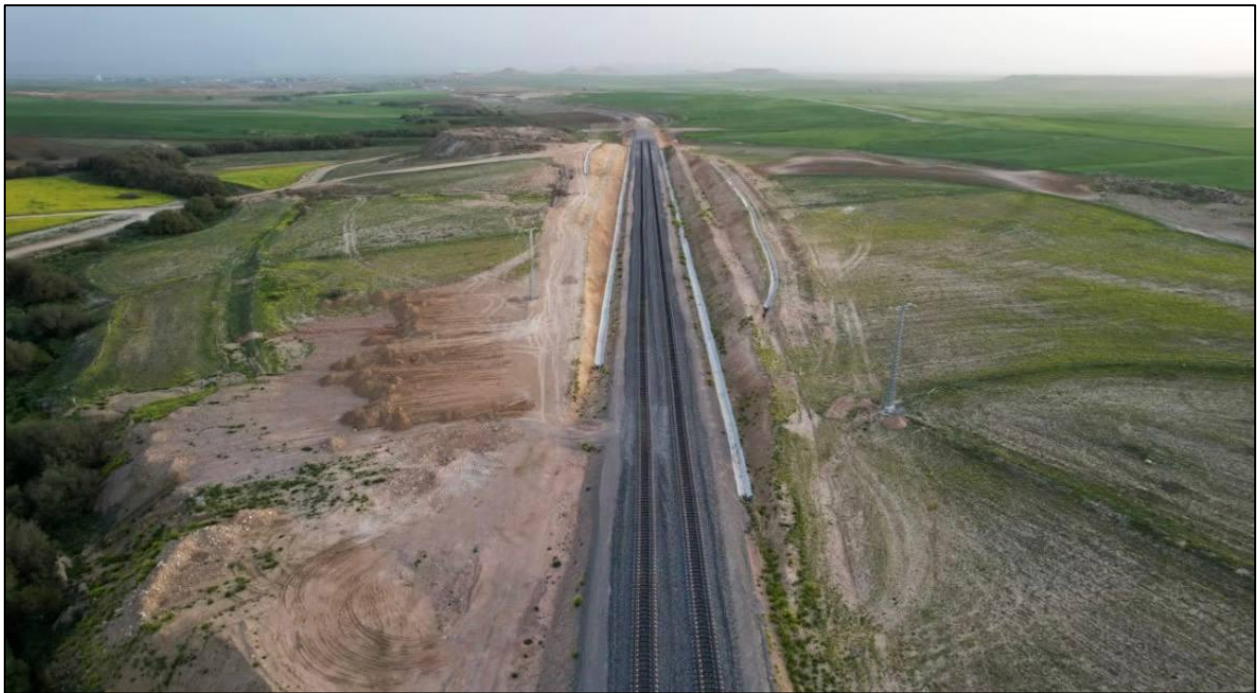
Figure XI-1 : Travaux de réalisation de la ligne minière Est « Tronçon Dréa-M'daourouch »
