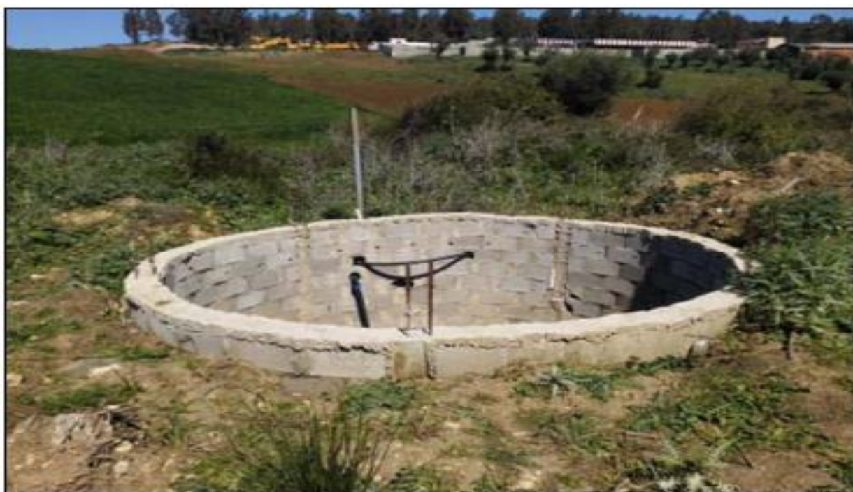
Figure VII.2 : puits réalisé au PK18+900 niveaux d'eau 3m.
