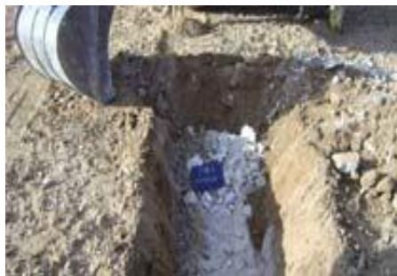
Puits de reconnaissance (Pk : 172+825)
