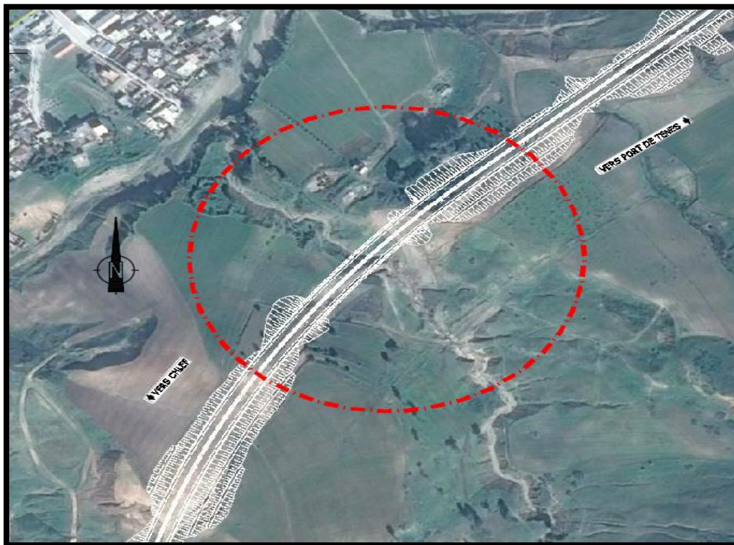
Figure I.1 : L'emplacement de l'Ouvrage D'art OA 26/01
