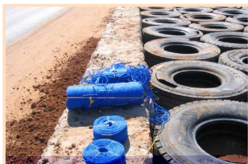
Photo.III.26. Exemple d'attaches en cordelette de nylon- cas de Mostaganem
