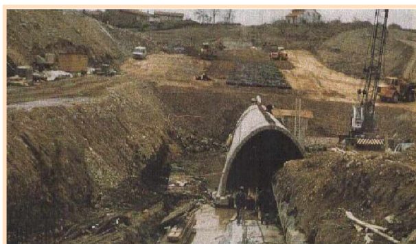
Photo.III.4. Répartiteur de contraintes au-dessus des conduits enterrés sous fortes hauteurs de remblai (Berne et al 1998)
