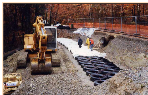
Photo.III.1. Remblai léger en crête de talus
