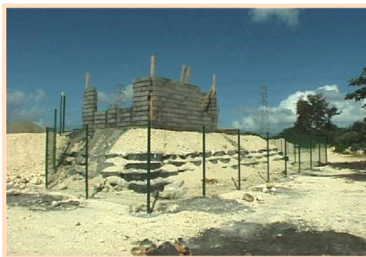
Photo.III.3. Site d'essai expérimental de N. T. LONG du Pneusol antisismique
