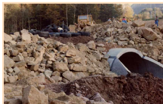
Photo.III.4. Répartiteur de contraintes au-dessus des conduits enterrés sous fortes hauteurs de remblai (Berne et al 1998)
