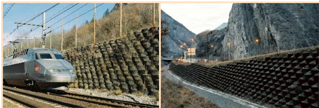
Photo.III.16.Exemple de protection contre les éboulements et les chutes de pierres
