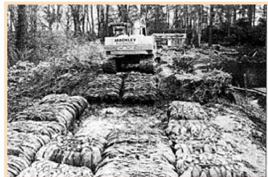
Photo.III.9. Utilisation en gabion des pneus entier
