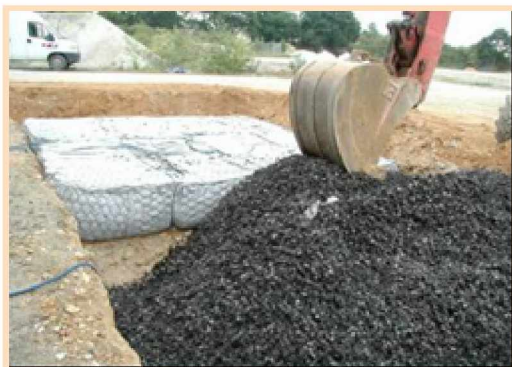
Photo.III.8. Utilisation en gabion et en vrac des granulats de Pneus sous forme de pastille
