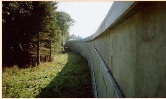
Photo.III.7. Soutènement avec parement en béton et renforcements en Pneusol
