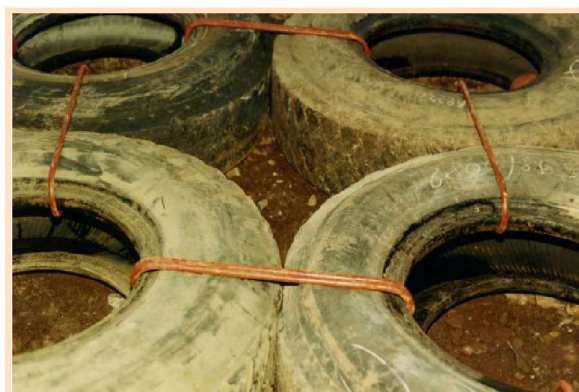
Photo.III.25. Attaches en crochets métalliques
