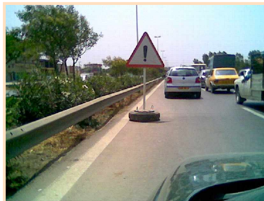
Photo.III.20. Support pour Panneau de signalisation Boufarik'
