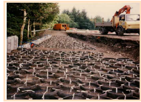
Photo.III.23. Système d'attaches en lanière
