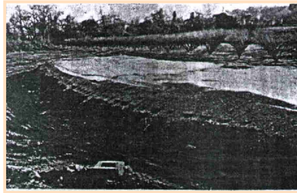
Photo.III.13. Section d'une route en technique pneusol
