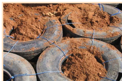
Photo.III.26. Exemple d'attaches en cordelette de nylon- cas de Mostaganem
