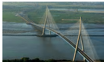
Figure II -6 : Pont de Normandie.
