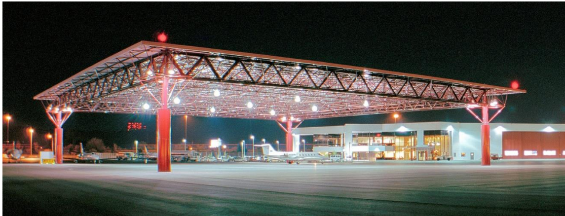
Figure 7.5 : Hangar d'aviation à Phoenix US
