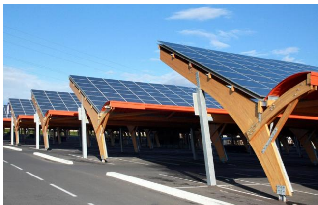
Figure 8.2 : les panneaux solaires
