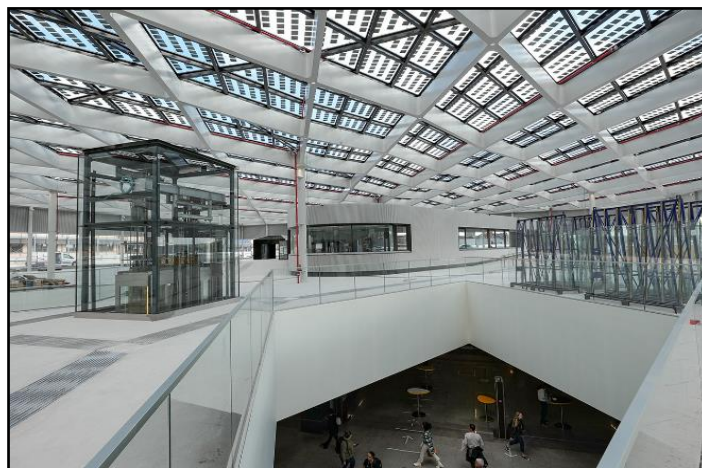
Figure 1.5 : Gare de Namur, structure mixte acier et béton
