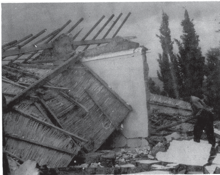
Habitation entièrement détruite - Séisme de Tipasa, 29 Oct. 1989 (Photo Doc. CGS)
