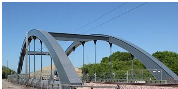
Figure II.5 : pont bow-string à Luxembourg.
