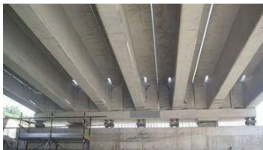
Figure II.1 : Pont à poutres précontraintes.
