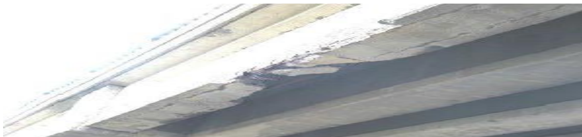
Figure I-3:Choc à cause des poids lourds hors gabarit contre l'intrados du pont.
