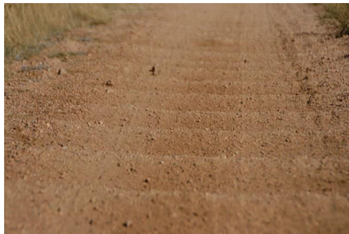
Figure III.15 Les tôles ondulées.
