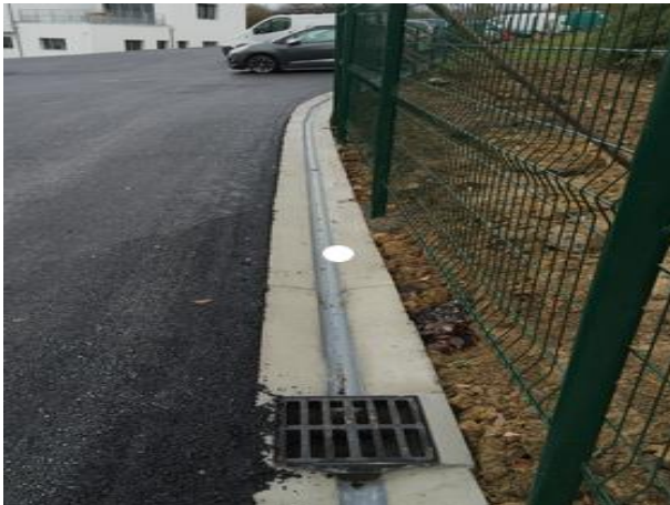
Figure VIII.3 Système d'évacuation des eaux superficielles (cunettes-avaloirs).
