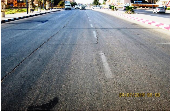
Figure V.17 Faiénçage à mailles larges au PR 1+100.
