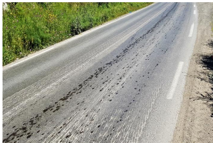
Figure III.29 Les remontées.
