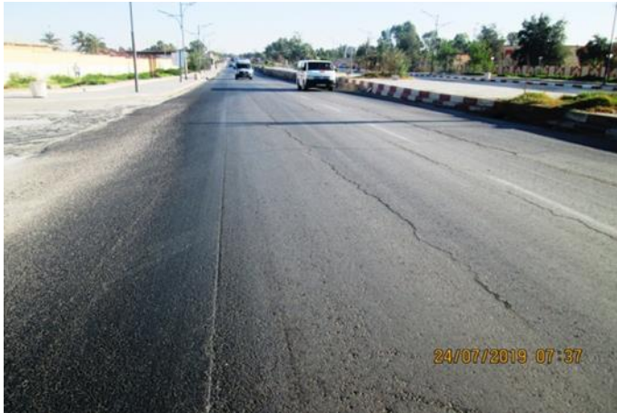
Figure V.7 Faïençage à mailles larges au PR 3+500.
