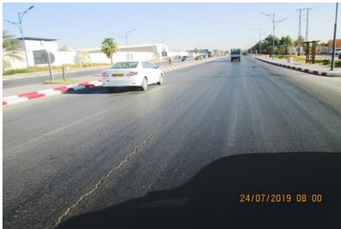
Figure V.15 Faïençage à mailles larges au PR 0+600.
