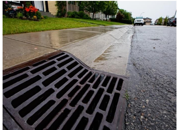
Figure VIII.3 Système d'évacuation des eaux superficielles (cunettes-avaloirs).
