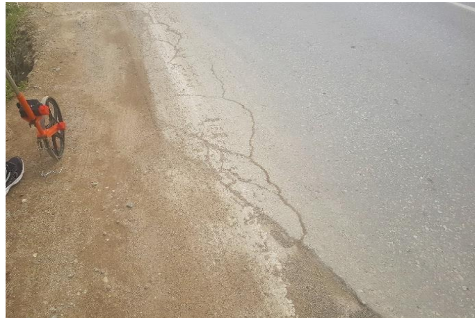
Figure III.24 Les épaufrures.
