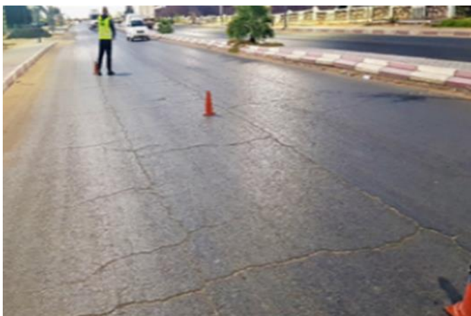
Figure V.22 Faïençage à mailles fines au PR 7+200.
