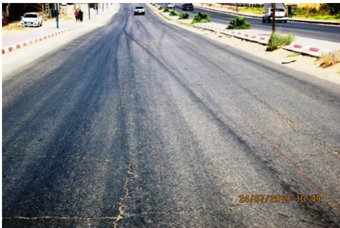
Figure V. 9 Faïençage à mailles larges au PR 5+100.
