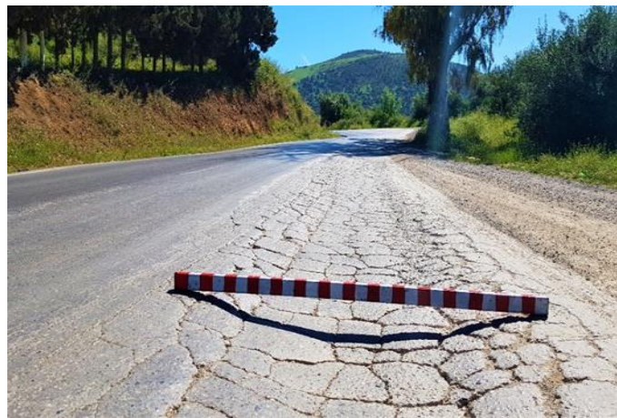
Figure III.12 Les affaissements.
