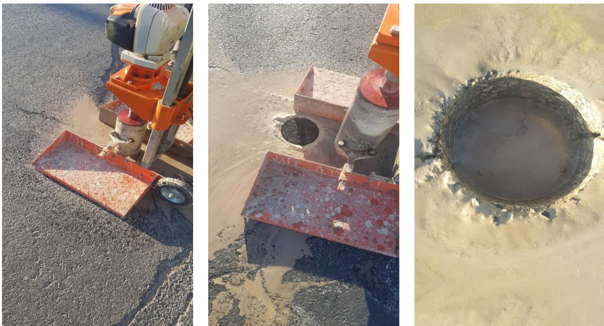
Figure V.1 Déroulement de la campagne de carottage.
