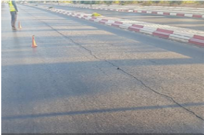
Figure V.11 Faïençage à mailles larges au PR 7+300.
