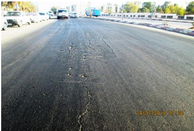
Figure V.5 Faïençage à mailles fines au PR 1+800.
