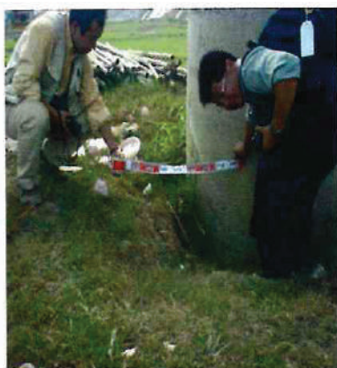
Fig.2.6 Tassements d'appuis (1999 Chi-Chi Séisme, Taiwan)
