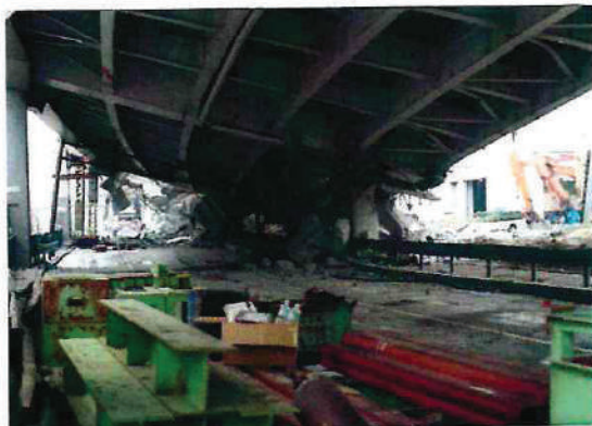
Fig.2.11 Poinçonnement des appuis dû à la force de séisme verticale importante (1994 séisme de LOS ANGELES)
