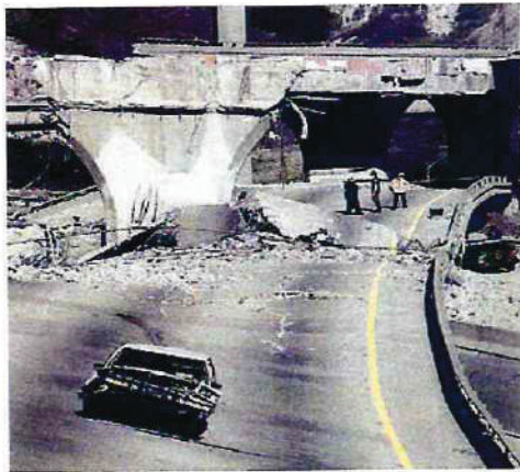
Fig.2.11 Poinçonnement des appuis dû à la force de séisme verticale importante (1994 séisme de LOS ANGELES)
