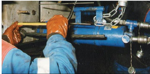
Figure.I.6. Mise en tension d'un monotoron. (2)
