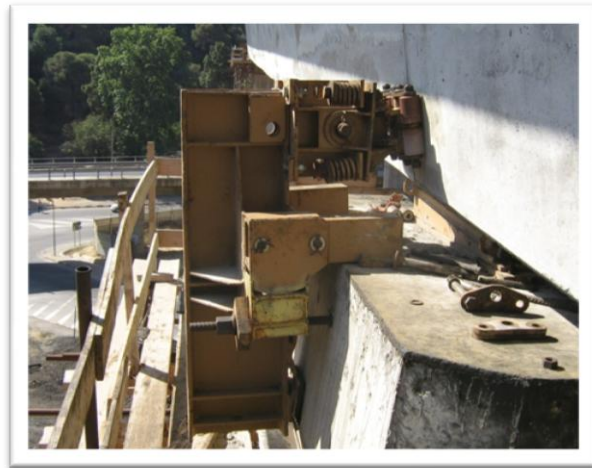
Figure(2.5) guide lateral sur pile
