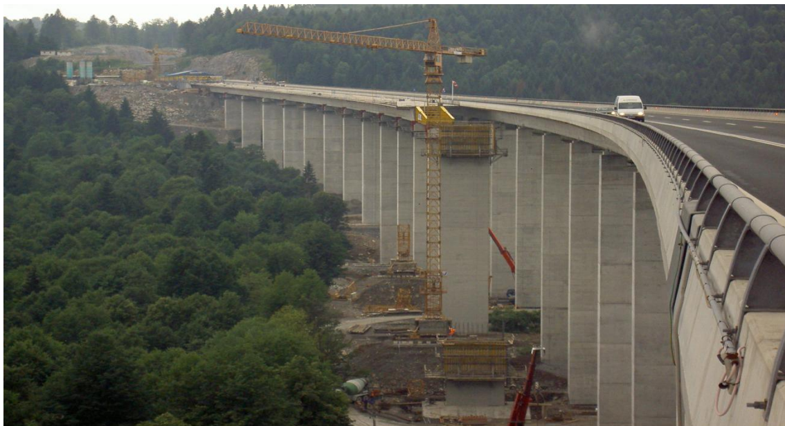
Figure A tablier construit par poussage
