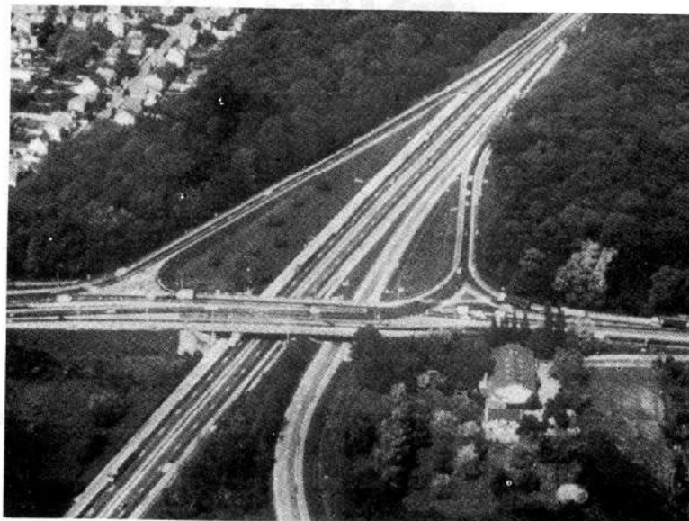
Croisement de 2 autoroutes (Photo Setra Doc., revue Equipement et Développement n°47 Sep 91)
