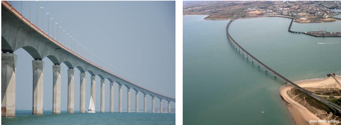
Figure 1.8 Le pont de l'île de Ré
