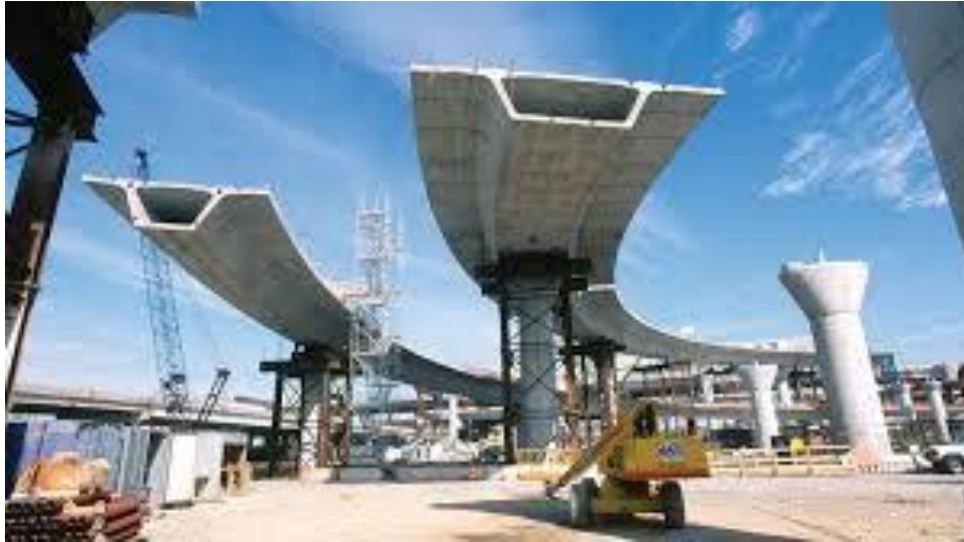
Figure II.2 : Pont voussoir préfabriqué en béton précontraint
