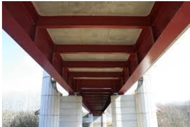
Figure III.1 : Exemple pont bipoutre
