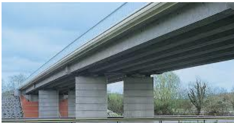
Figure II.1 : Pont à poutres précontraintes (VIPP)
