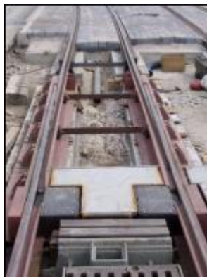
Figure VII.5: Appareil de dilatation ferroviaire ADF
