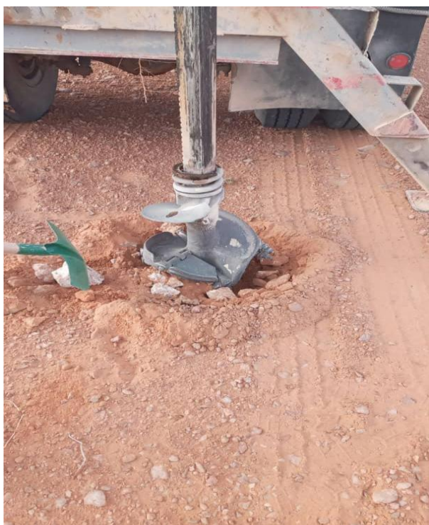
Photo de la fin de l'excavation du puits
