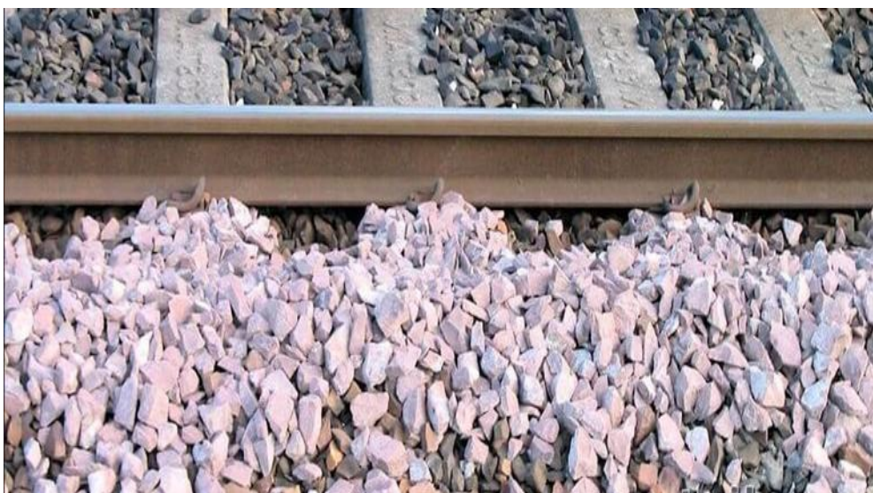
Figure VIII.2 : Ballast sur la voie [3]
