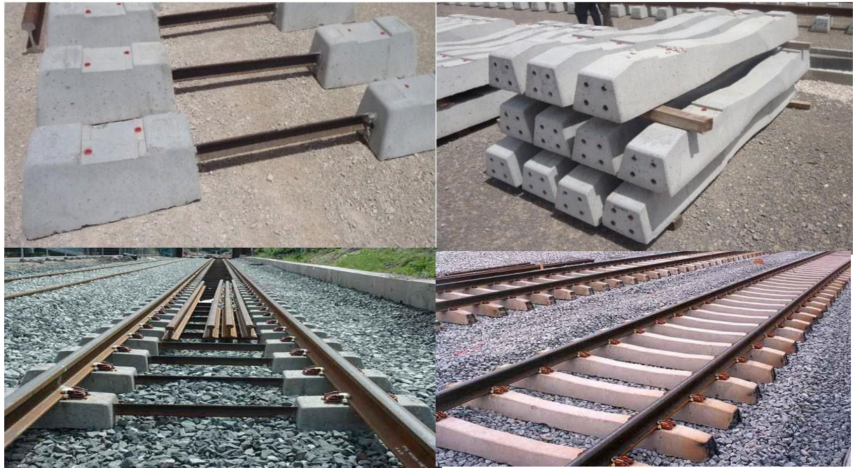
Figure III.3 : Traverses en béton (Traverses bi bloc /Traverses mono bloc) [3]
