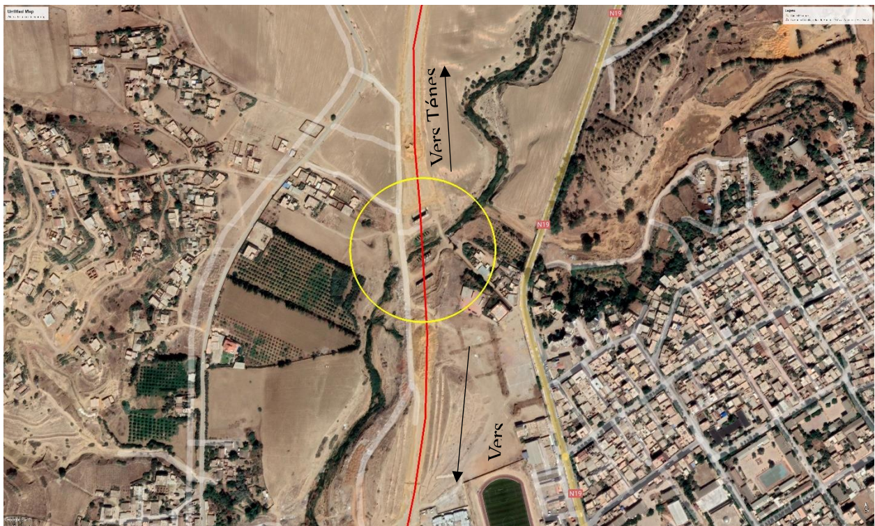
Figure II. 1: L'emplacement de l'Ouvrage D'art OA 34/02 (Source : Google Earth).
