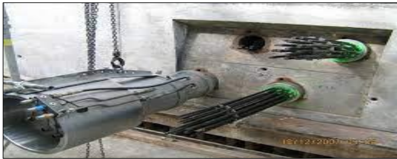
Figure I. 6 : Mise en tension d'un câble (Post-tension)
