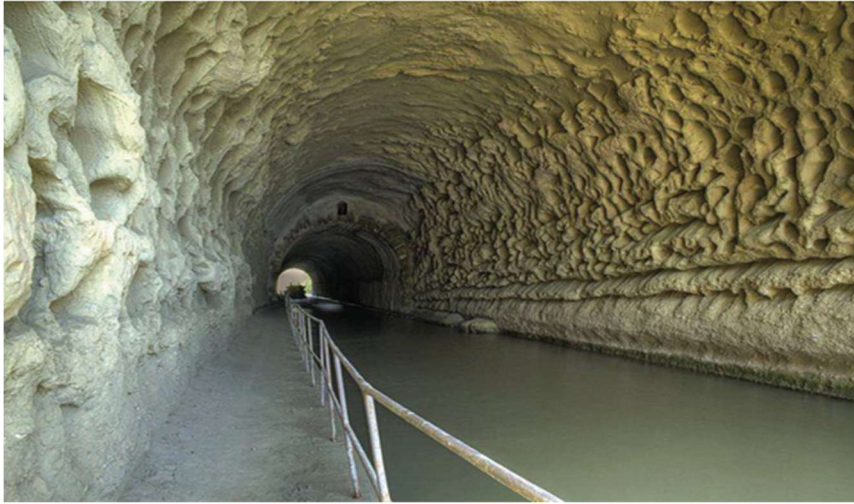
Figure I-1 Tunnel de Malpas Canal Du Midi 1680
