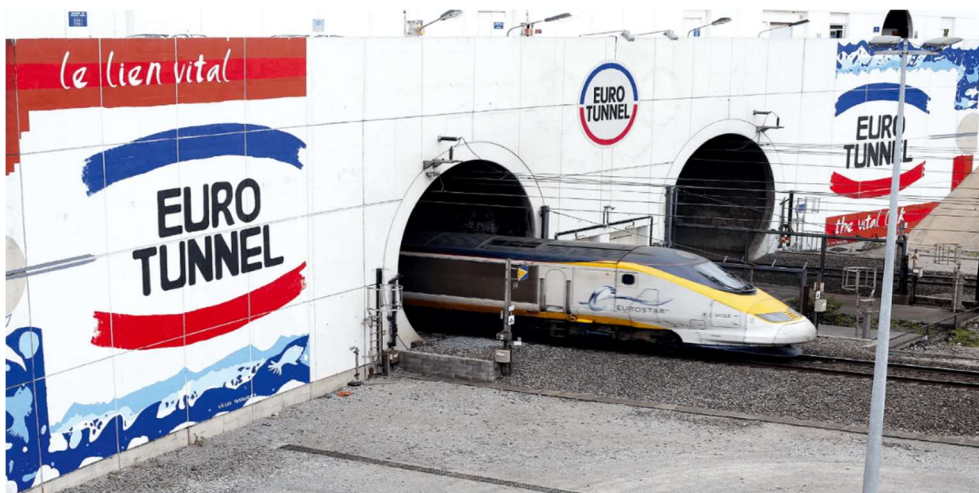
Figure I-3 Tunnel sous la manche 1994
