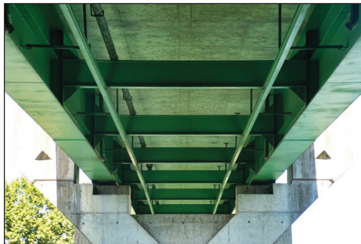
Figure III. 5 : Vue transversale des éléments du tablier bipoutres.
