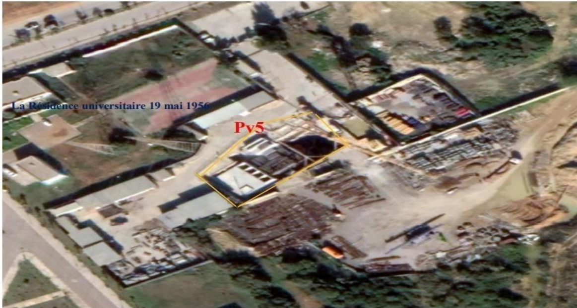
Figure I.6 : Localisation de PV5 dans photo Google earth
