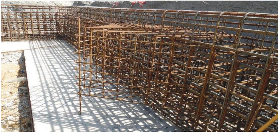
Figure II.14 : Ferrailage d'un massif d'appui
