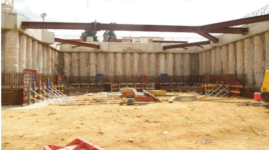
Figure II.13 : Mise en œuvre de la poutre intermédiaire
