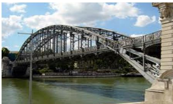
-Pont en arc à tablier intermédiaire-
