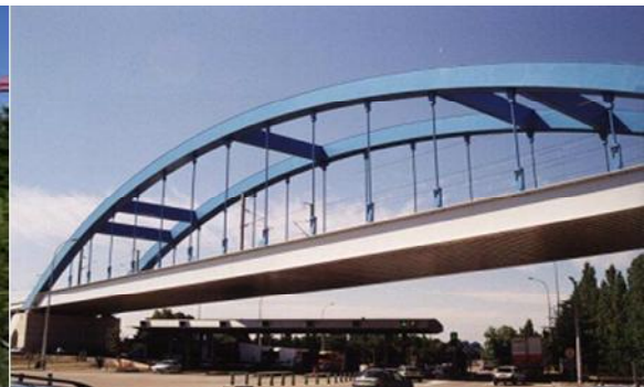
- Pont en arc à tablier inférieur-
