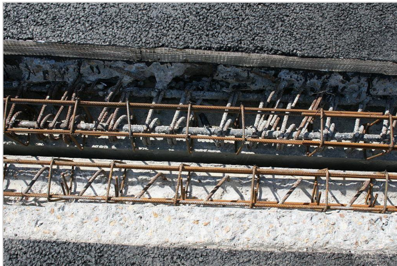
Figure I. 9 Réservation du joint de chaussée
