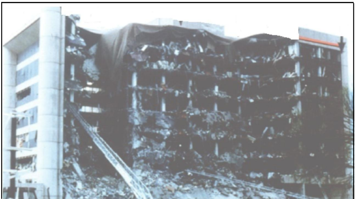
Figure 7-21 : Effondrements progressifs de la structure
