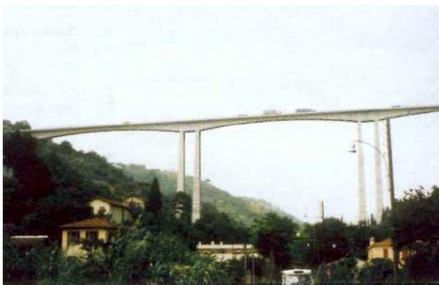
Figure 1 - Viaduc du Magnan (doc. SETRA)
