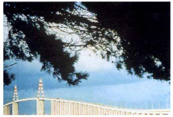
Figure 2 - Viaduc d'accès au pont à haubans de Saint-Nazaire (doc. SETRA)
