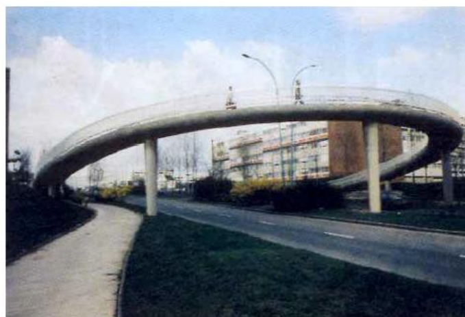
Figure 3 - Passerelle (Amiens) (doc. SETRA)
