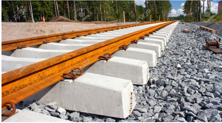
Figure I.3 Traverse en béton.
