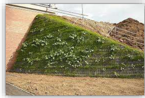
Fig V.1 : renforcement par la géogrille
