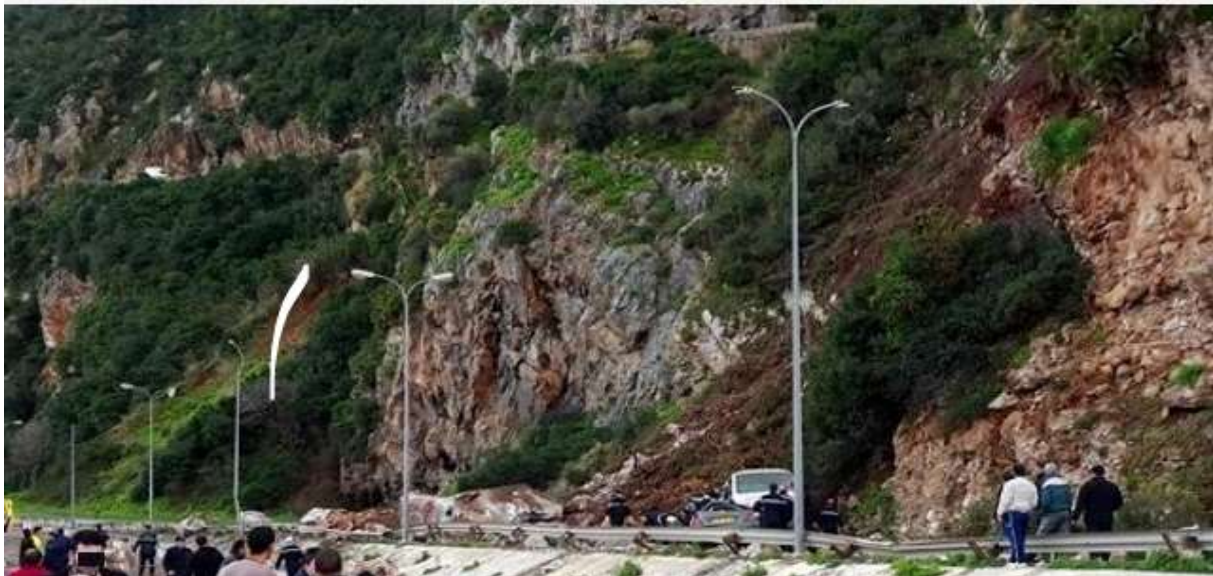
Fig.III.1: Cas du glissement de terrain au niveau de Bejaïa (Aokas) [4]
